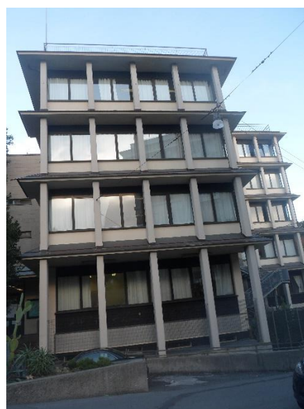
Figura 4.4 - Particolare dei serramenti
