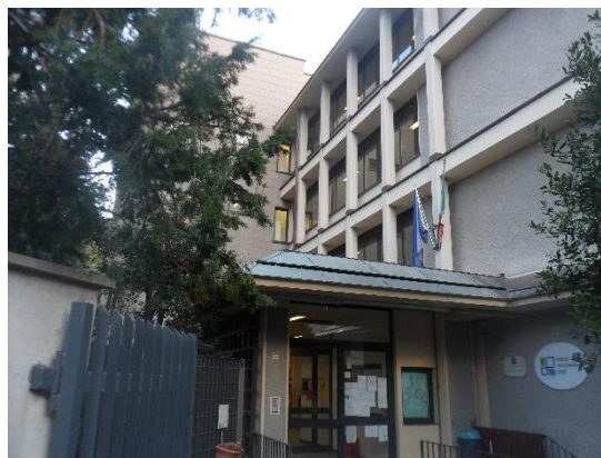
Figura 1.1 - Vista della facciata
